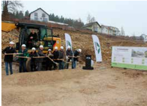
Mit dem Baggerbiss im Beisein der Planer, Objektbetreuer und dem Wohnbau-Team fiel der Startschuss für den „Wohnpark Beim Heiligental“ in der Möhringer Vorstadt. Foto: A. Villing / Perle Stadtmagazin
